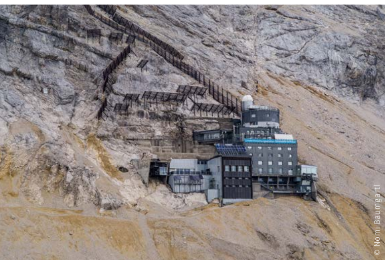
Station de recherche environnementale Schneefernerhaus - Zugspitze
